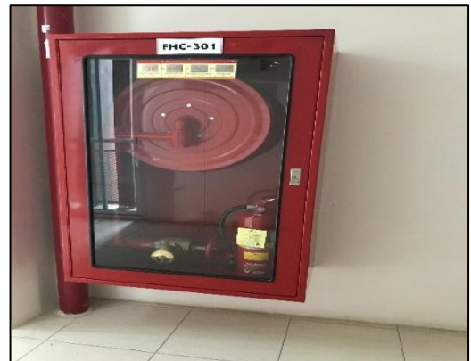
รูปที่ 5 สายฉีดน้ำดับเพลิง
